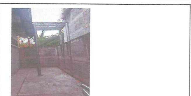
Foto 6: Instalacion de base metalica para tanque de agua
