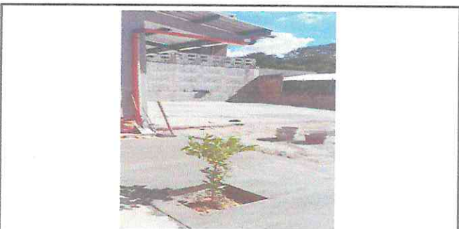
Foto 4: Torta de concreto
